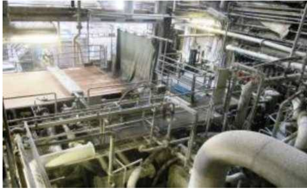
Станция очистки войлока
